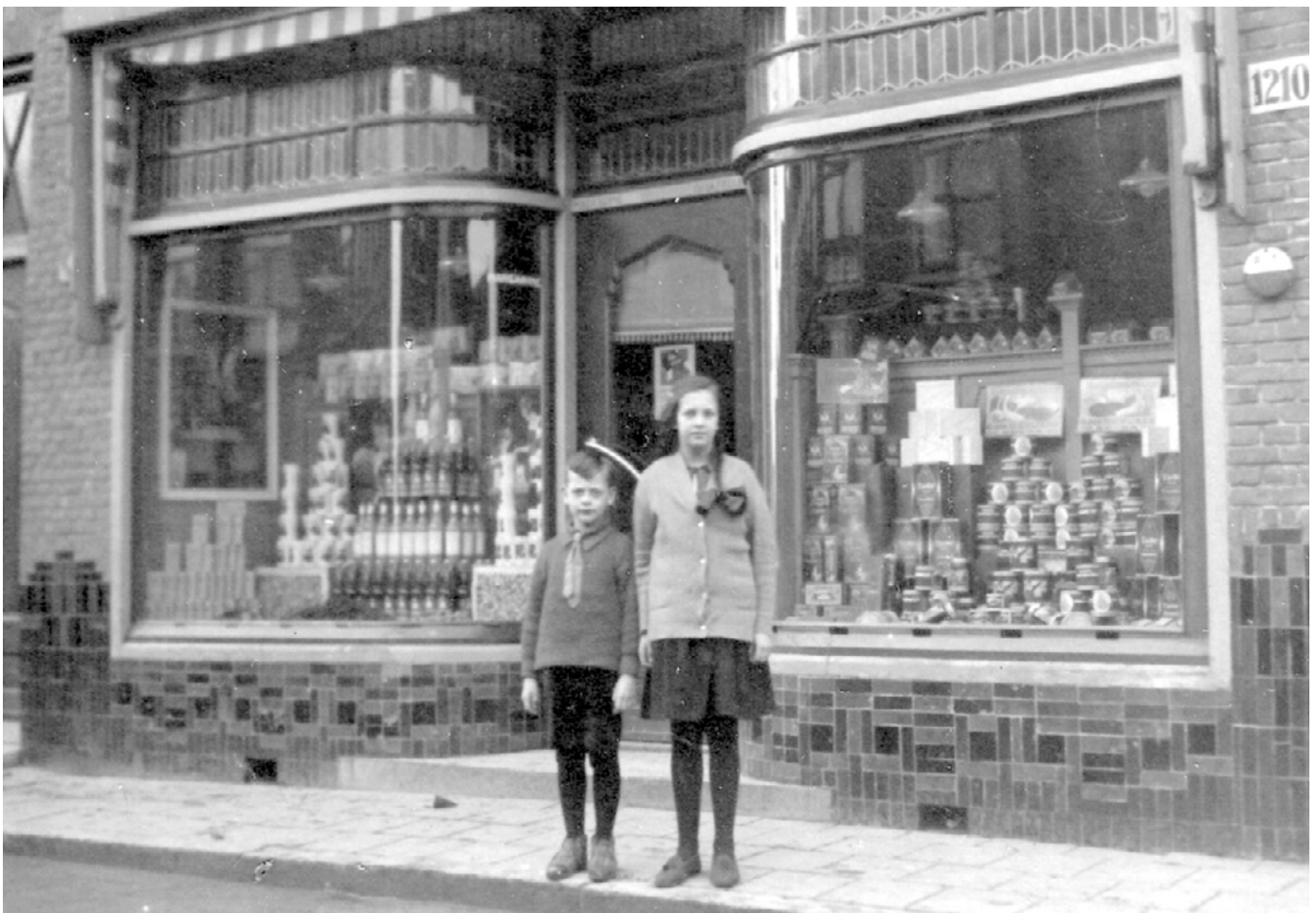
Sloterweg 1210-1212. Het in 1922 door architect L.J. de Wolf gebouwde woon- en winkelpand toont hoe tijdens een periode van voorspoed onder de middenstand van Sloten, de dorpskern zich verdichtte en een schaalvergroting onderging. Daarnaast zijn voor deze plek de gaaf bewaarde winkelpui en de hierbij behorende interieur elementen zeldzaam. Foto uit 1924 met zoon en dochter van kruidenier In't Veld voor de winkel.
