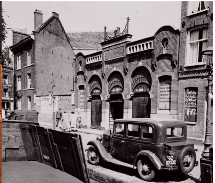
Lijbaansgracht, herbouw van de voormalig Nassaubioscoop. Na jarenlange discussie over de restauratie werd de gevel uiteindelijk herbouwd in combinatie met nieuwe woningen. Toestand 1953 en foto na de herbouw.
