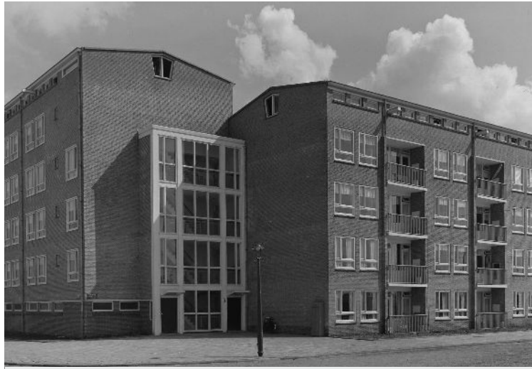
METSELWERK MET GATEN EN ORNAMENTEN
