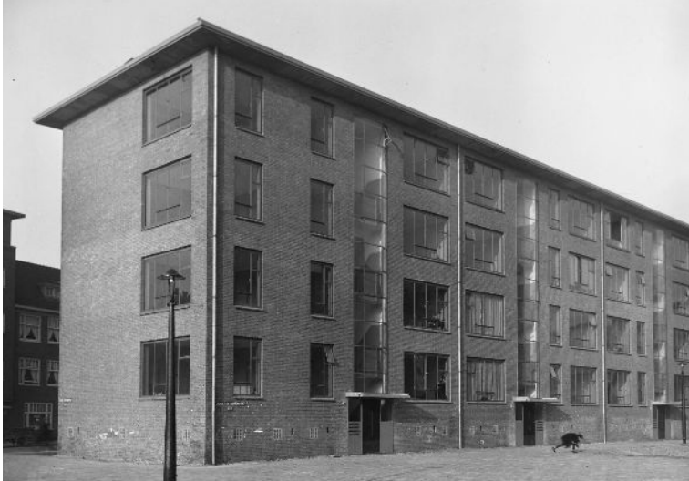
METSELWERK MET GATEN
